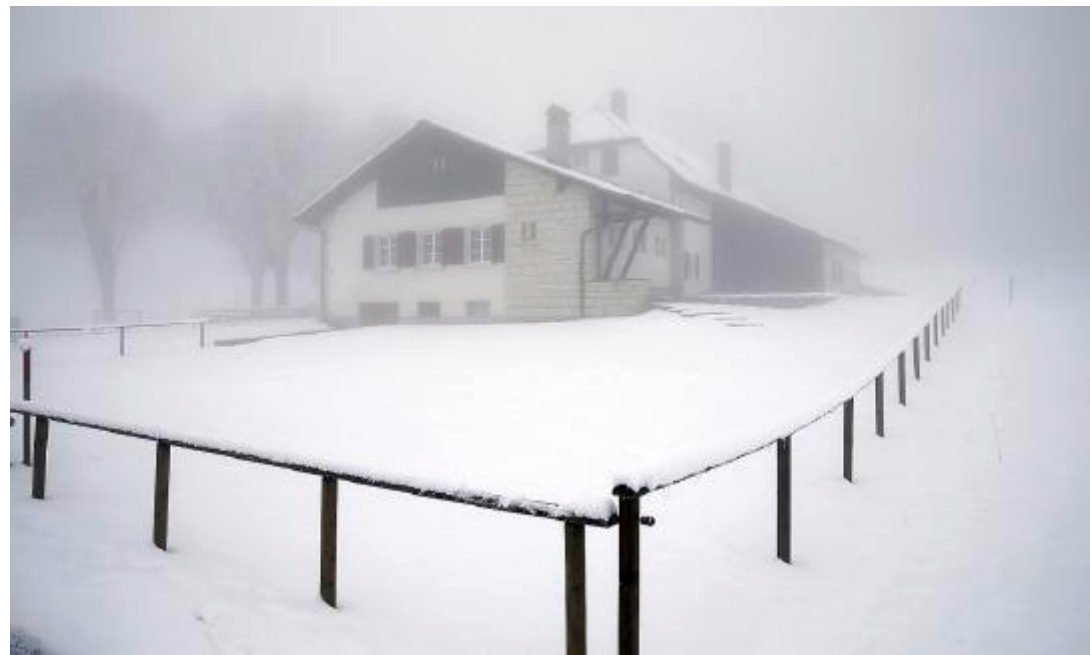
Bundeseigenes Ausflugsrestaurant: End der Welt, eben für anderthalb Millionen Franken saniert.
